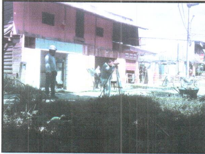
TRAZO, NIVEL Y REPLANTEO EN OBRA
