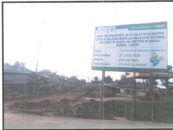
VISTA DEL CARTEL DE OBRA
