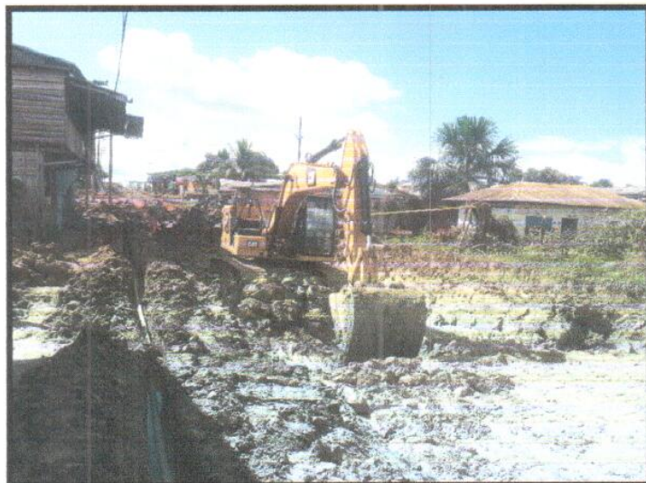
CORTE DE TERRENO A NIVEL DE SOBRE EXCAVACIÓN, PROGRESIVA 0+500
